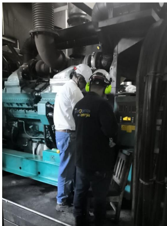
Personal técnico durante la intervención a la unidad de generación.
