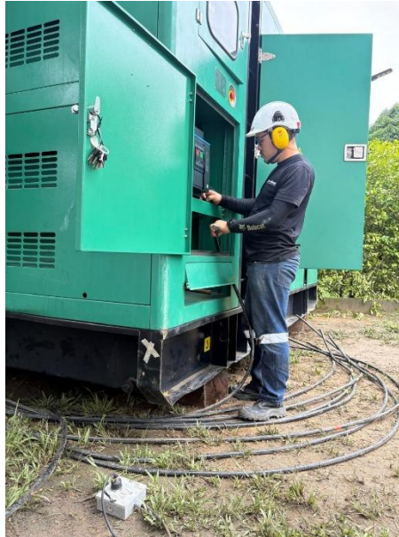
Técnicos trabajando en las conexiones finales
