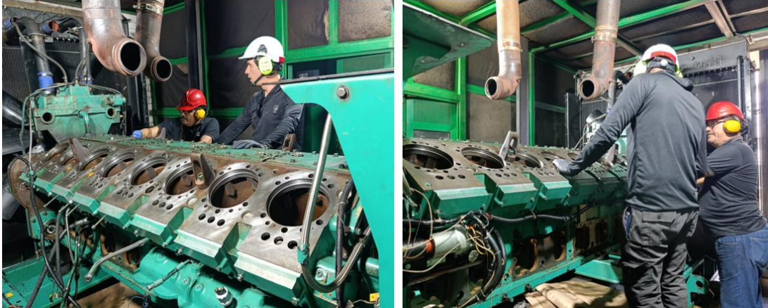
Personal técnico avanza con el mantenimiento de la Unidad 9
