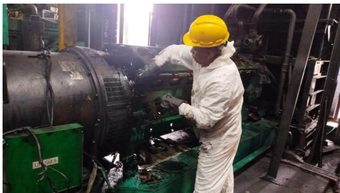
Mantenimiento de la Unidad 5 de Inírida
