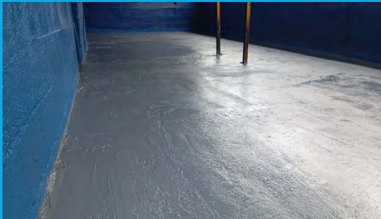
Nivelada y aplicada de pintura epóxica
