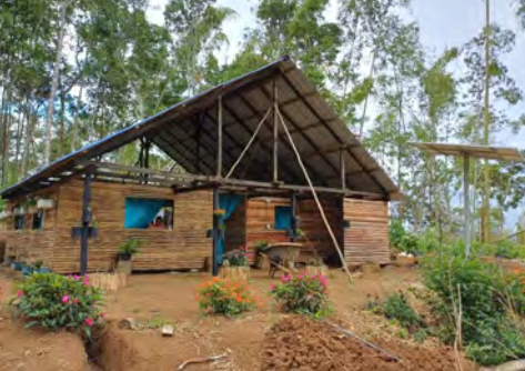
Municipio de Dagua, vereda La Cristalina. Vista General de la vivienda
