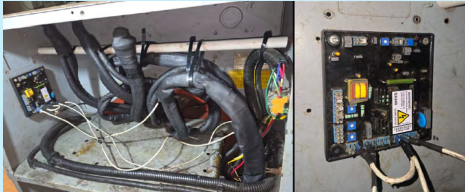
Mantenimiento al sistema de control.
