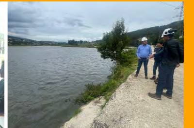
Visita del Presidente de GENSA a la comunidad para tratar los temas de la vía afectada y torres de enfriamiento.
