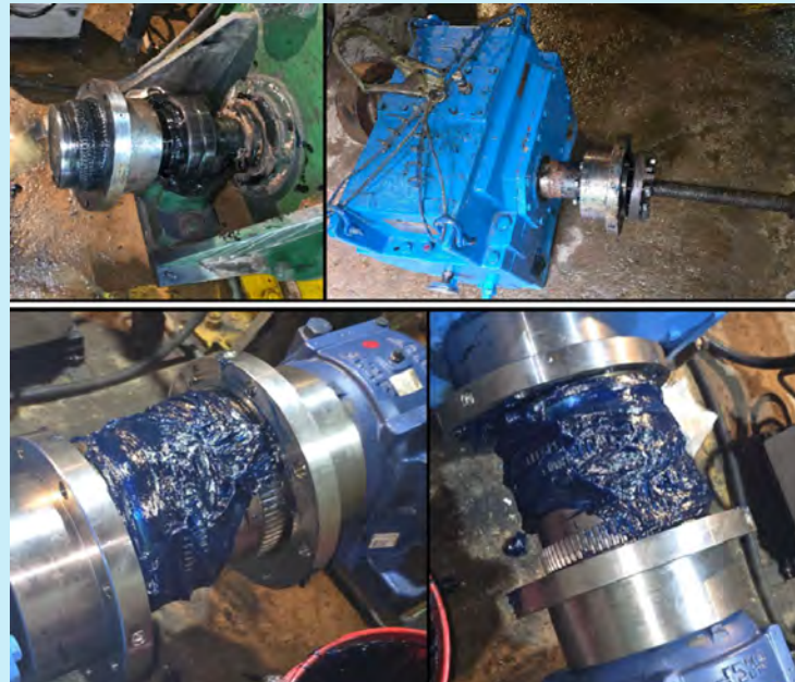
Instalación del nuevo acople.
