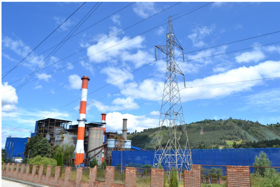
Fachada principal de Termopaipa
