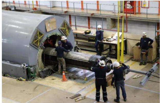
Proceso de extracción del rotor del Generador de la unidad 3
