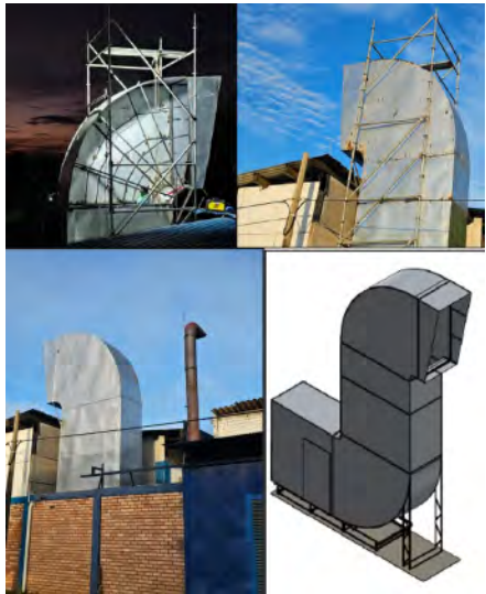
Montaje de estructura difusora para conducción de ruido y aire caliente en la unidad 8 de la central diésel de Mitú.
