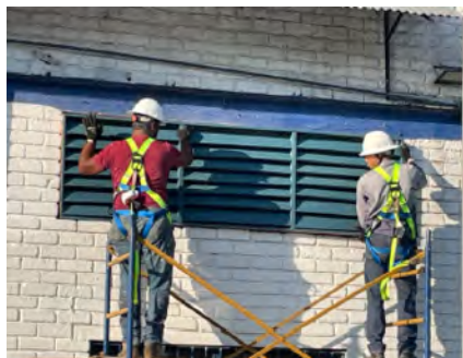
Instalación de persianas para evitar ingreso de agua en buques abiertos en central diésel de Mitú
