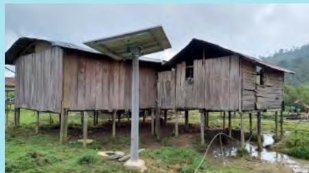
Vivienda ubicada en la vereda Cañaveral, municipio de Dabeiba, departamento de Antioquia.
