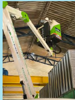
Corrección de goteras central diésel de Mitú
