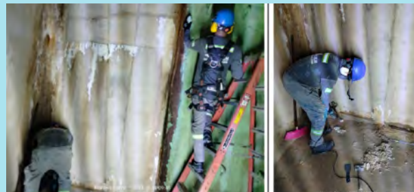
Inyección de epóxico para sello de fisuras en muros de PCH Mitú
