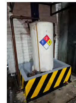
Mejoramiento diques de contención en tanques de igualación central diésel Mitú
