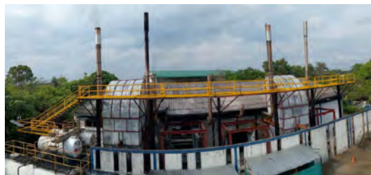
Pasarela terminada y con acabados finales
