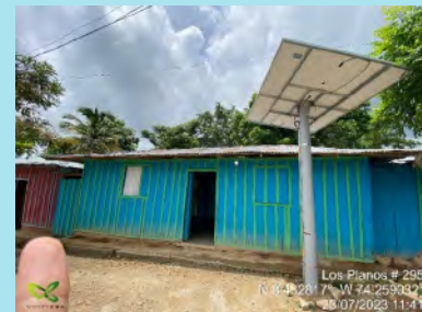
Vivienda ubicada en la vereda Los Planos, municipio de Tiquisio, departamento de Bolívar.
