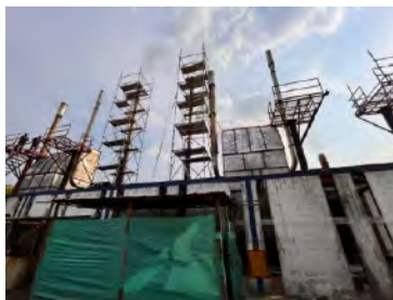
Construcción e izaje de conductores de ruido y aire caliente, modificación de chimeneas.
