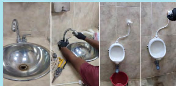
Reparación de filtraciones en unidades sanitarias de la PCH Mitú.
