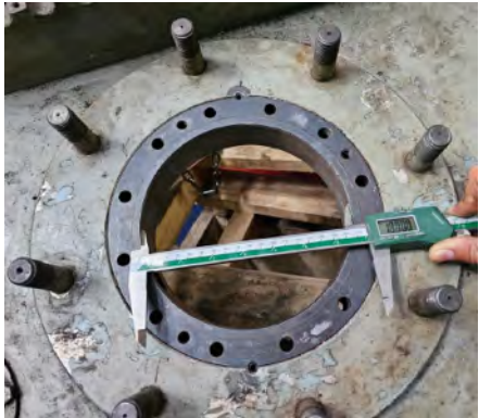
Montaje de casquillo en tapa trasera
