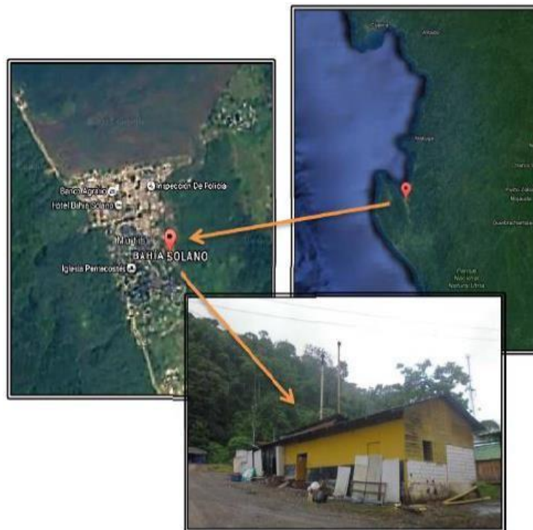
Casa de máquinas de la Central de Generación Diésel de Bahía Solano, cuando no existían asentamientos humanos a su alrededor.
