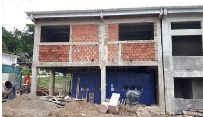
Intervención estructural de la Central Diésel de Bahía Solano.
