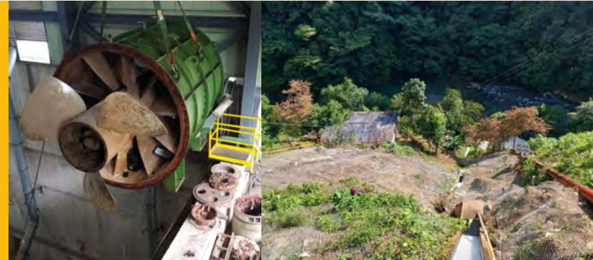
Izaje del bloque hidráulico unidad 3 PCH Mitú.
