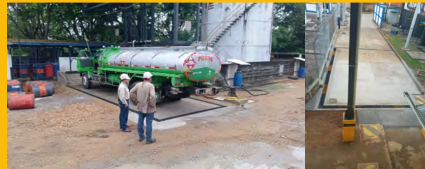
Canal de aguas hidrocarburadas, Inírida.
