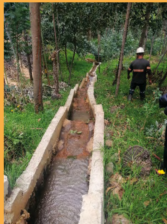
Zonas perimetrales de inversiones Cibor
