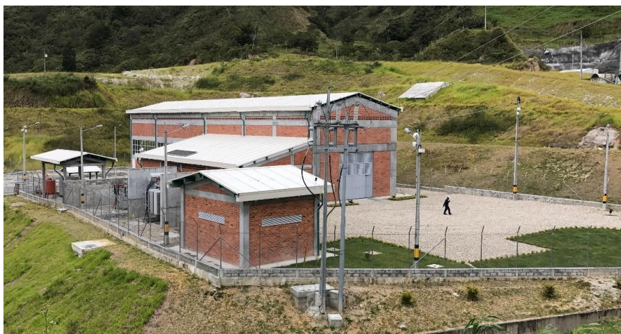
Ilustración 31. Cerramiento casa de máquinas, Fuente: fotografía tomada por GENSA en visita técnica a la PCH La Alejandría.
