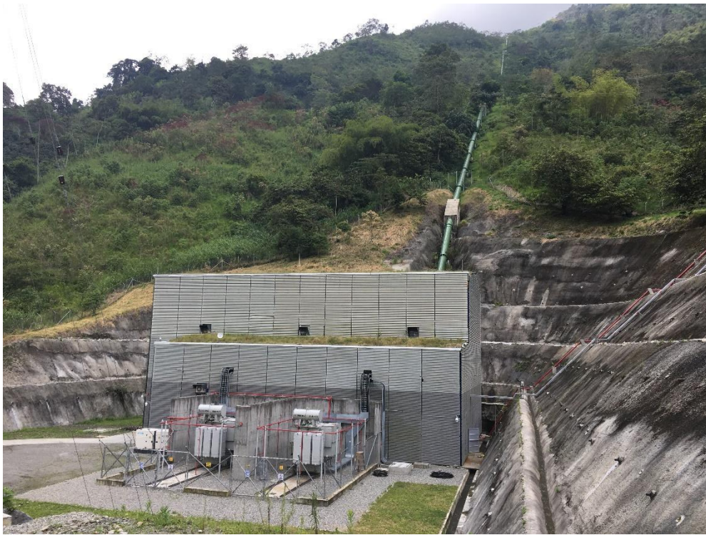
Ilustración 9. Tubería de carga y Casa de máquinas. Fuente: PCH El Edén
