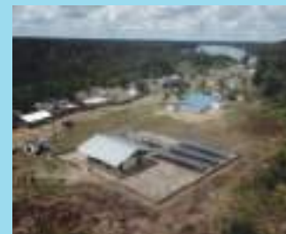
Central de generación fotovoltaica de 36,45 kWp en la localidad de Remanso (Guainía). Usuarios atendidos: 61
