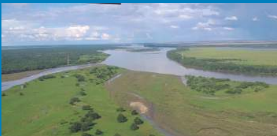
Vista aérea del cruce del Río Meta Línea 115 kV
