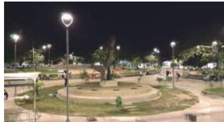
Modernización alumbrado público de La Dorada (Caldas)
