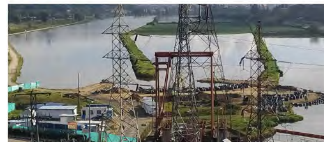
Gestión para adelantar el proyecto de torres de enfriamiento
