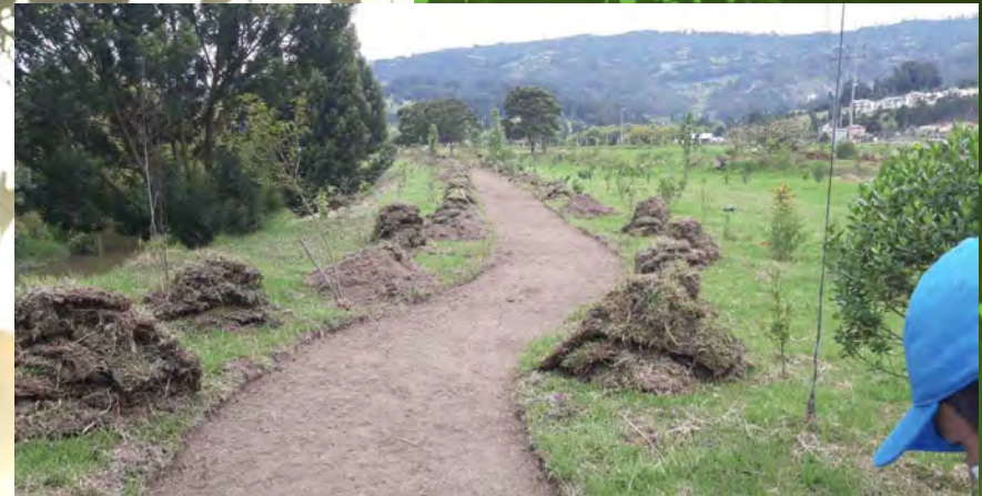
Adecuación del sendero ecológico de Termopaipa
