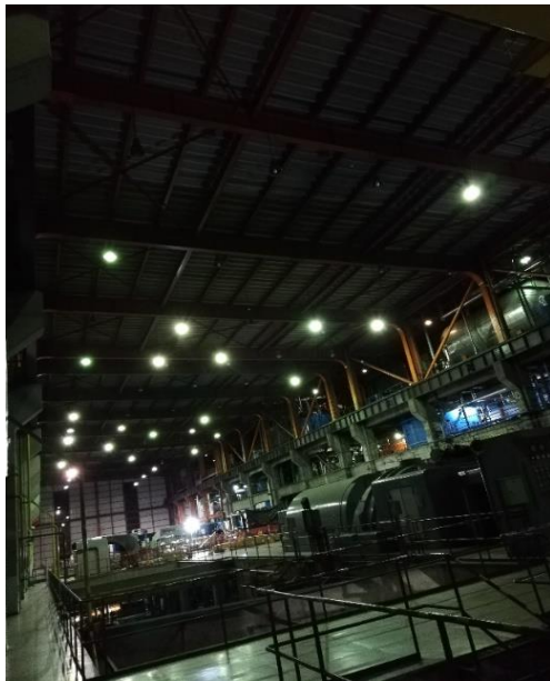
Antes - Iluminación turbogeneradores
