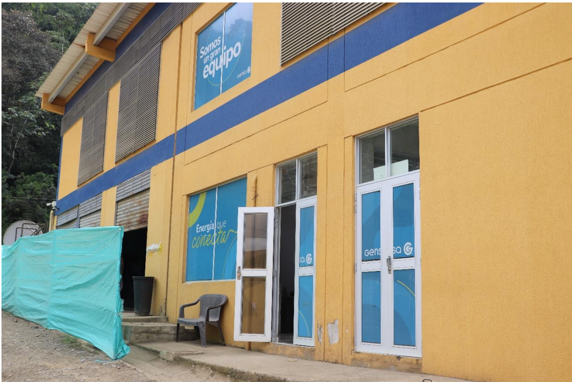
Fachada de la Central Diésel de Bahía Solano (Chocó)
