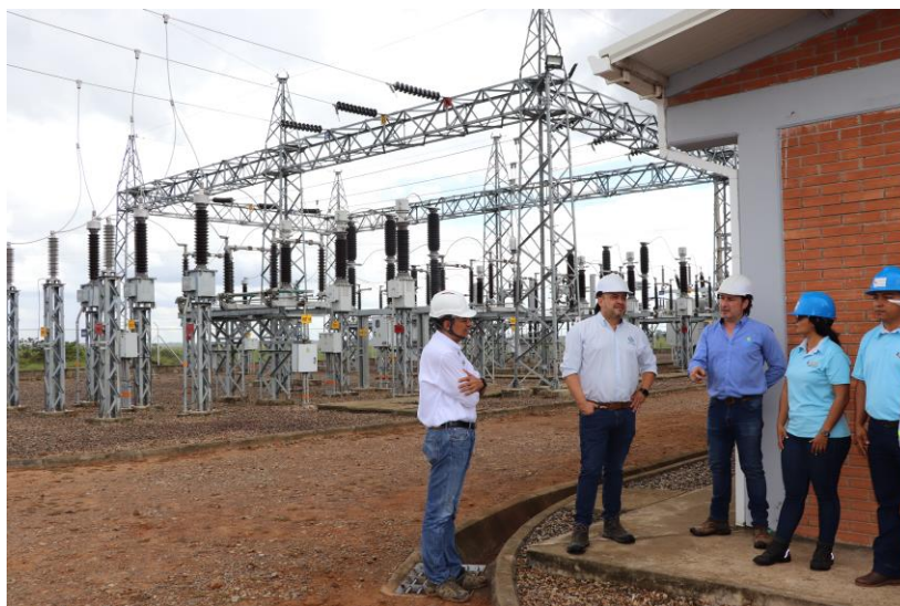
Aspectos del recorrido de una de las subestaciones del proyecto, en Santa Rosalía, Vichada.
