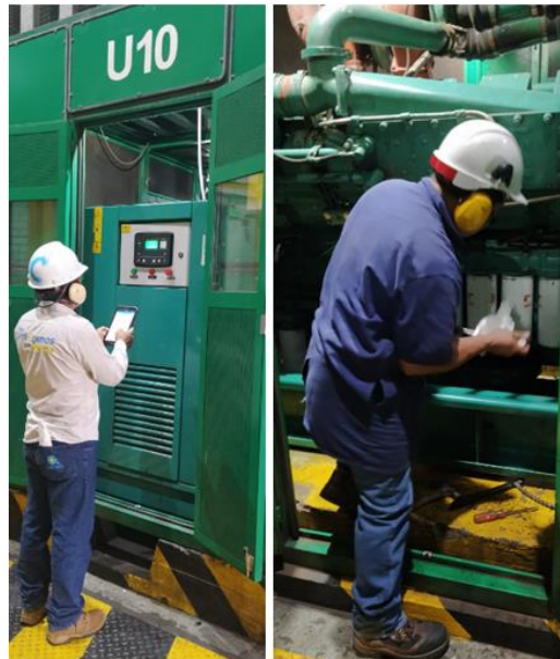
Labores de rutina de operación y mantenimiento
