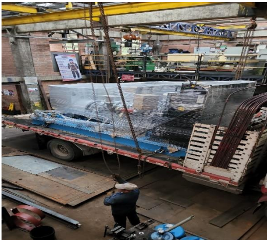
Alistamiento de la nueva unidad de generación
