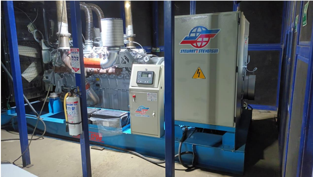
Instalación de grupo electrógeno en la Central Diésel de Bahía Solano - Chocó
