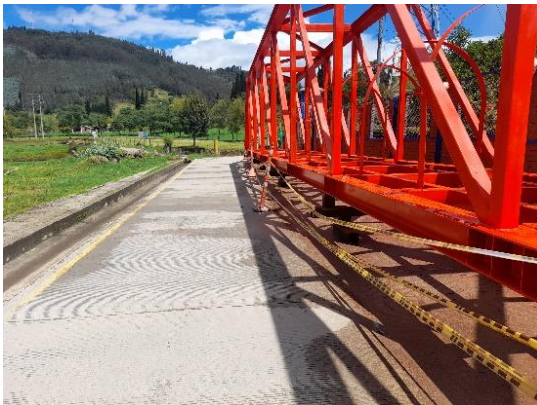
Estructura que se pasará sobre el río Chicamocha
