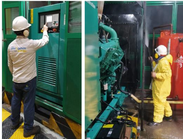
Labores de rutina de operación y mantenimiento
