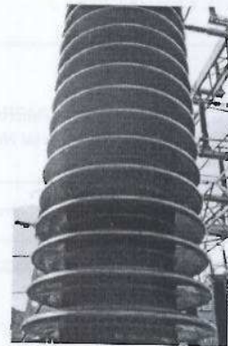
Envolvente-Exterior en Porcelana Presenta mugre externamente.
