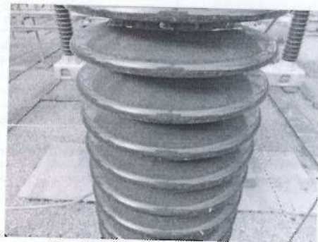
Envoltorio-Exterior en porcelana Presenta mugre externamente.
